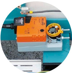
Tirette d'aération avec servomoteur
